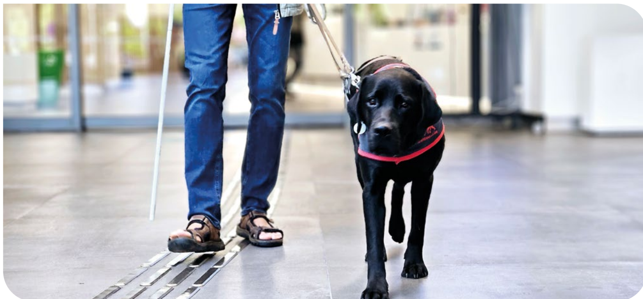
Ces lignes au sol en relief aident les déficients visuels à s'orienter.
